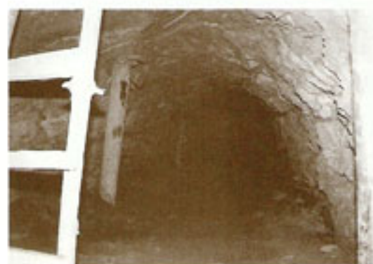
Miniera Perticara (PESARO) Sistema di uscita dello zolfo fuso dai forni Gili Foto 1930 - Archivio Carlini
