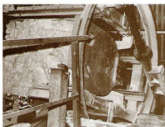
Miniera Floristella (ENNA) Scarico (rovescello) automatico del minerale negli impianti di tramoggiatura Foto Carlini, 1980
