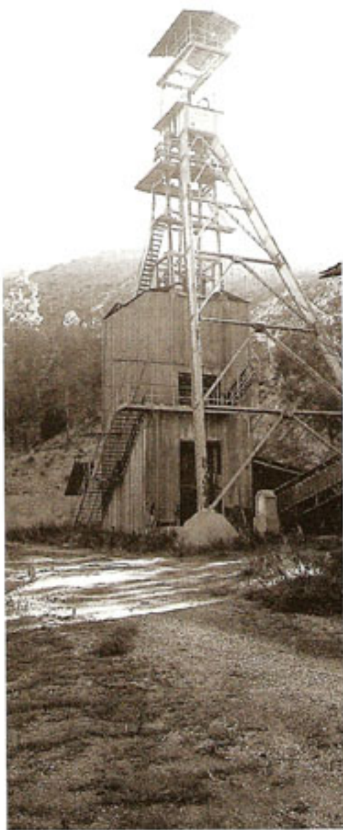
Miniera Giumentaro (ENNA) Veduta del pozzo principale Foto Carlini, 1994
