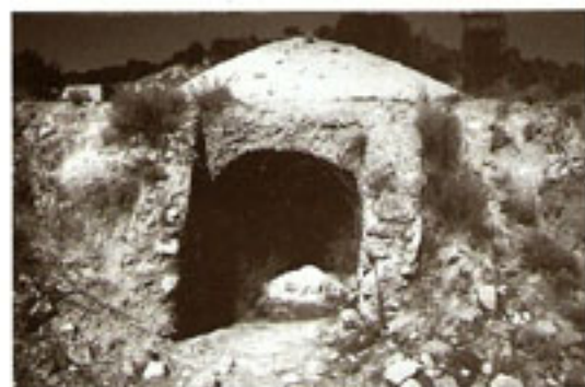
Miniera Floristella (ENNA) Veduta di quel che rimane di un vecchio calcarone (forno di fusione dei primi del secolo) Foto Carlini, 1994
