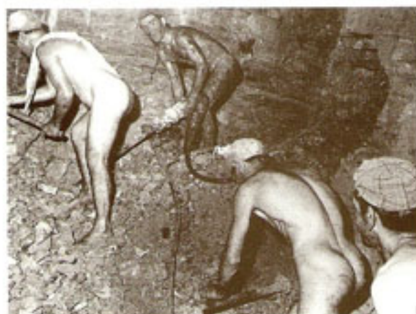
Lavoro in miniera, picconieri con perforatore nel fronte di avanzamento Foto 1920 circa - Archivio storico del sindacato minatori della CGIL di Enna
