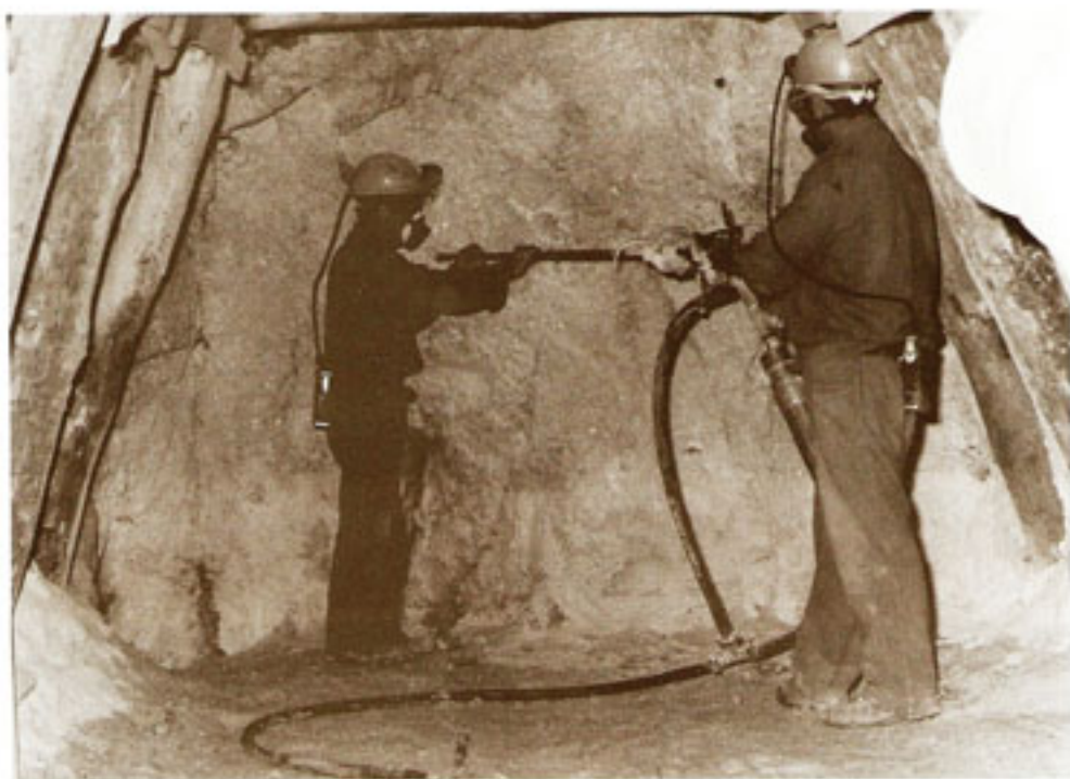
Miniera Floristella (ENNA), Lavoro in galleria con martello perforatore (preparazione dei fori per le mine) Foto Carlini, 1994
