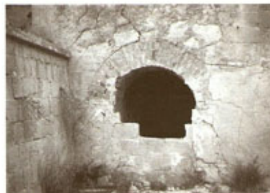
Miniera Giumentaro (ENNA) Veduta dell'ingresso chiuso di una galleria Foto Carlini, 1994
