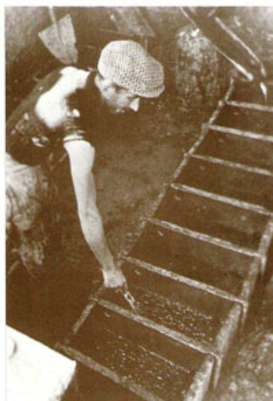
Miniera Perticara (PESARO) Minatore addetto alla preparazione dei pani di zolfo Foto 1935 - Archivio Carlini
