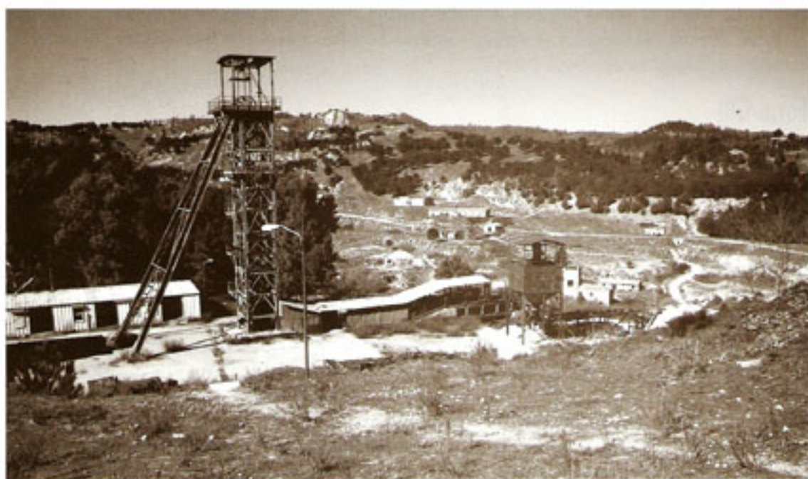
Miniera Giumentaro (ENNA). Veduta del pozzo principale Foto Carlini, 1994
